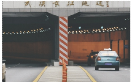
武汉长江隧道 Wuhan Yangtze River Tunnel
