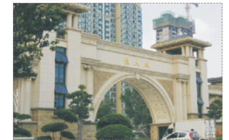
山东泰安恒大城 Shandong TaiAn-Hengda City
