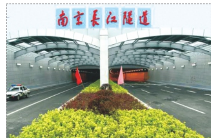
南京长江隧道 Nanjing Yangtze River Tunnel
